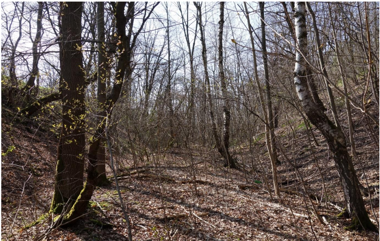
Auch hier ist das ehemalige Planum noch gut erkennbar. Der Blick zeigt in Richtung Bahnstrecke Stollberg – St.Egidien.
