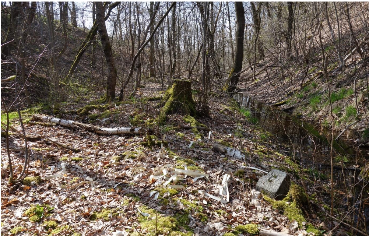
Wenige Meter nach dem vorherigen Bild ist der sächsische Hektometerstein 2 zu sehen. Er befindet sich noch in korrekter Lage im 45^\circ -Winkel zur Gleisachse. Der Bahnentwässerungsgraben erfüllt ebenfalls noch seinen Zweck. Der Taleinschnitt scheint an dieser Stelle am tiefsten zu sein.
